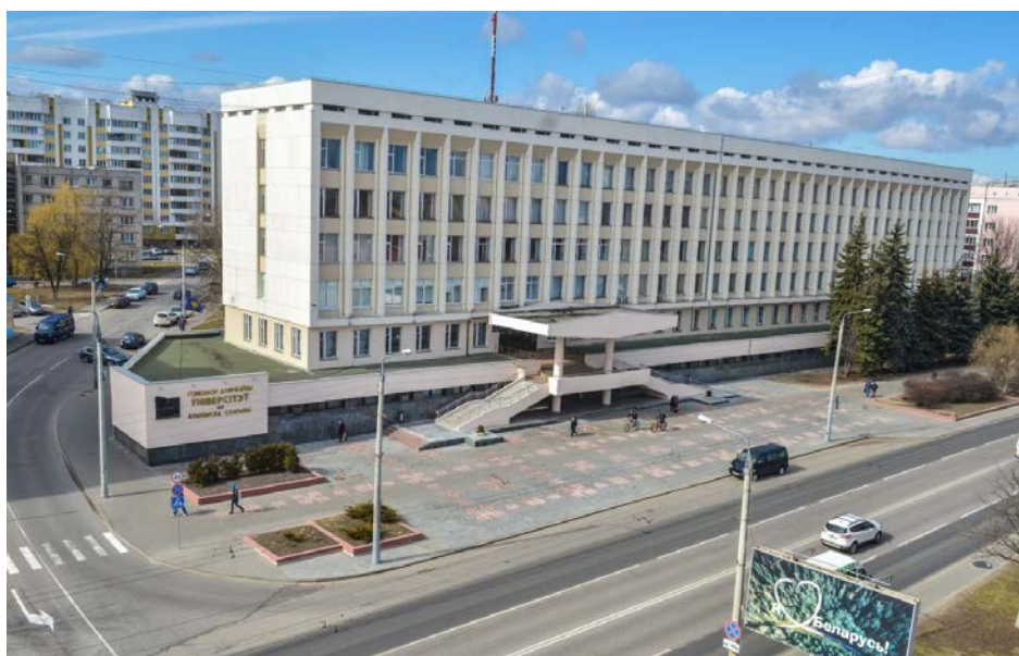
Рисунок 1 – Главный корпус университета
